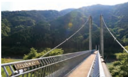
▲南アルプス接岨大吊橋は、高さ30mの安定した構造。
